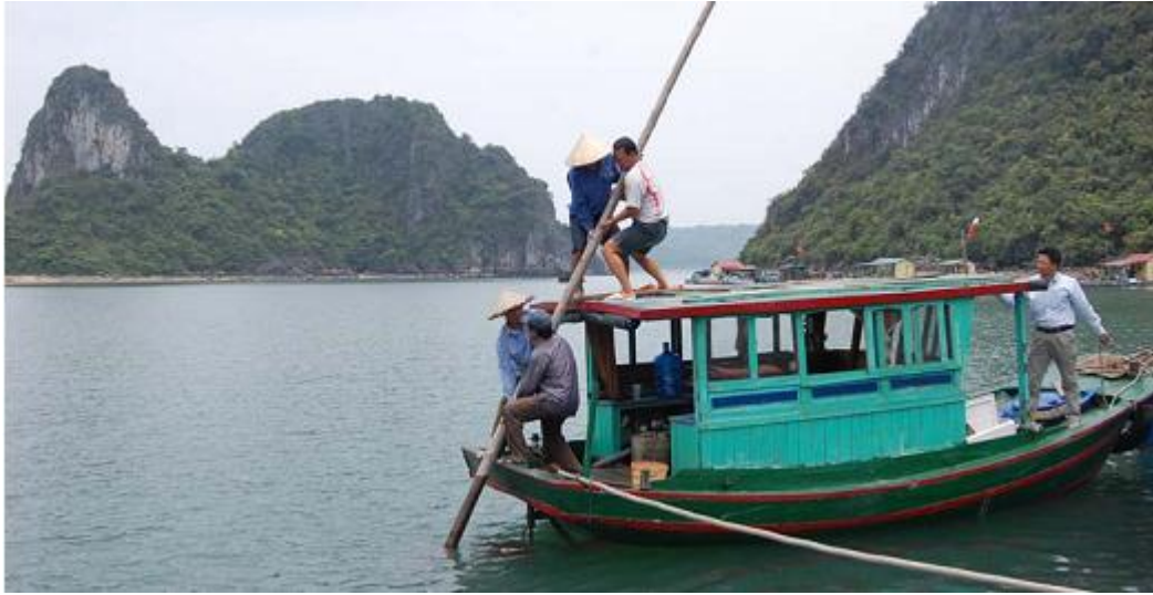
Hình 2.7. Đóng cọc neo bằng gỗ
