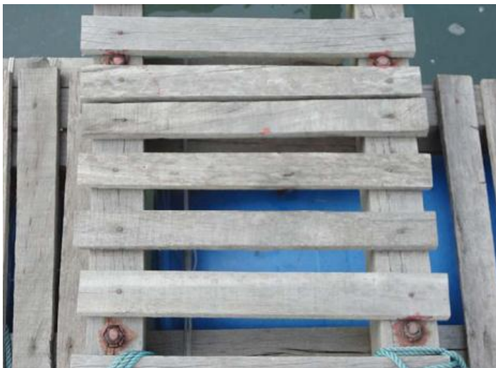
Hình 1.8. Cố định khung lồng bằng bu lông, ốc vít
